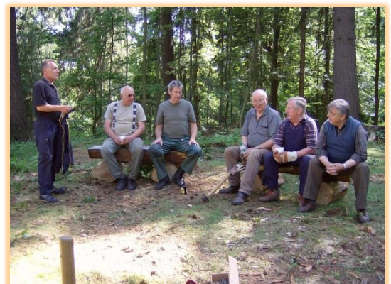
Die Baugruppe errichtet Holzbänke unter den alten Fichten.
